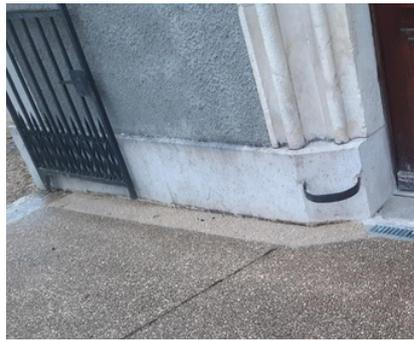
Pose d'une rigole pour l'évacuation des eaux pluviales devant la porte d'entrée de l'église.
